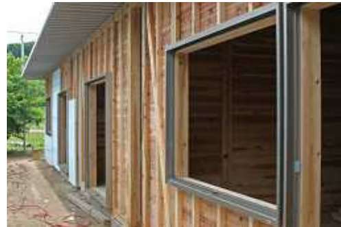
ペアガラステラス窓 内壁は杉板30ミ
