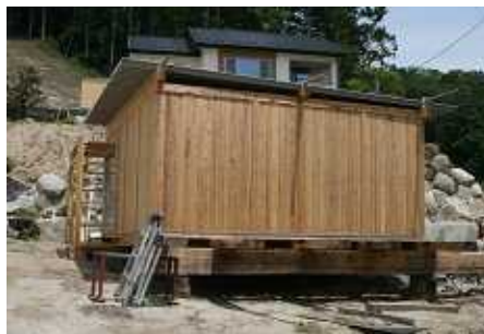
杉断熱パネル落とし込み工法
