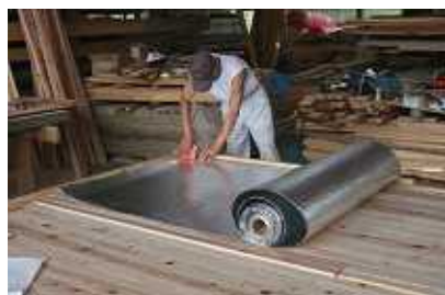
断熱反射シートを挟み込む
