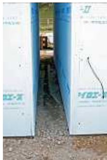
住戸間の隙間
